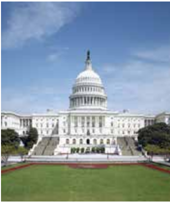
国会大厦的西侧俯瞰国家大草坪。
