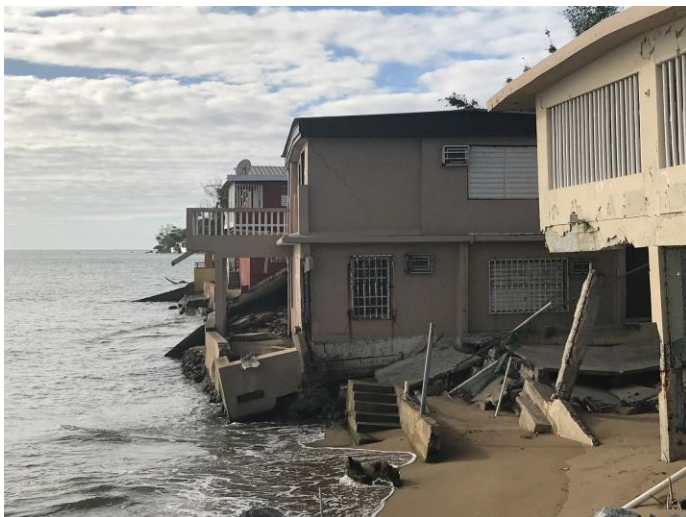
Imagen 9. Estructuras situadas cerca de la orilla y sujetas a desgaste y erosión.
