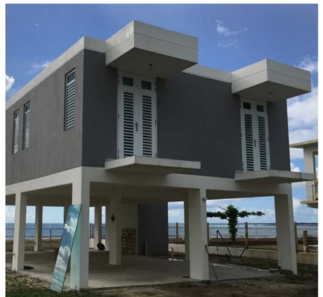
Imagen 12. Una estructura costera bien construida con su elemento más bajo sobre el BFE.
