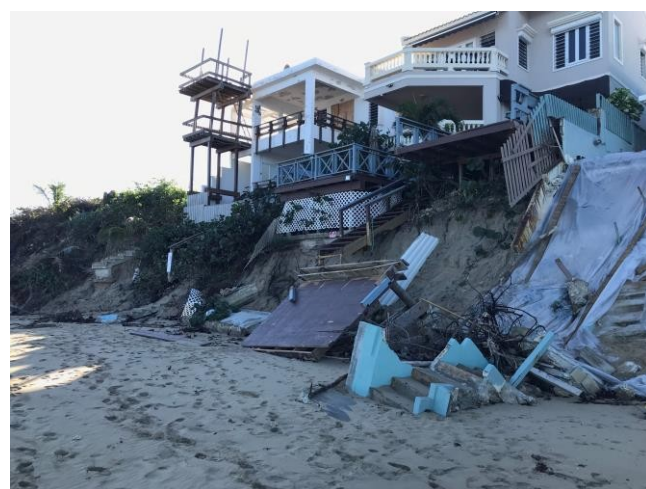
Imagen 5. La estructura socavada por la erosión experimentada durante el huracán María en la playa Shacks.
