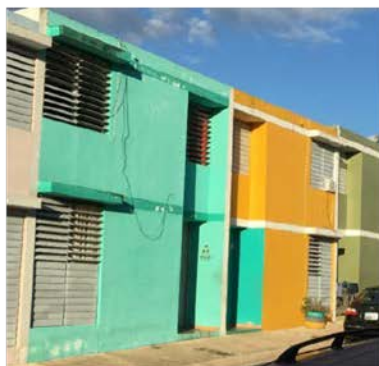
Imagen 3. Unidades de vivienda nuevas seguras con aperturas con celosías de metal.
