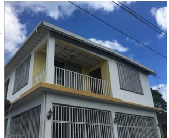
Imagen 10. Residencia de dos pisos con ventanas y puertas con cristal (balcón del segundo piso) protegidas con torneras de panel de metal.
