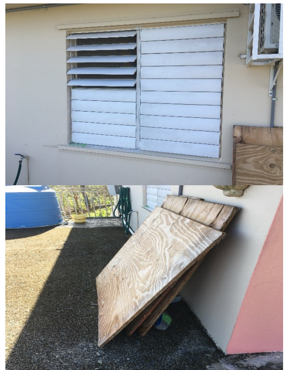
Imagen 14. Arriba: ventana con celosías de metal protegida contra los escombros arrastrados por el viento por paneles de madera, abajo, durante los huracanes Irma y María.
