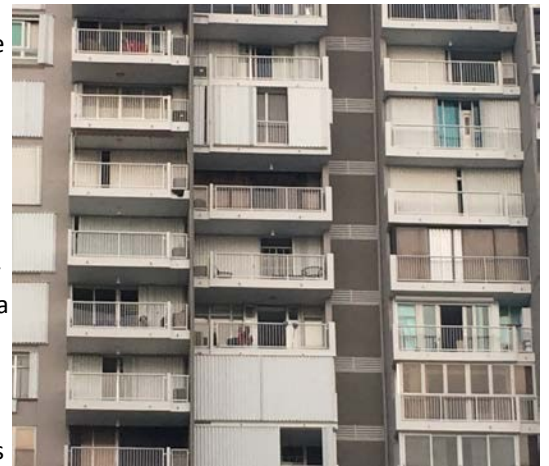
Imagen 11. Torre residencial en la que alrededor del 85% de las unidades cuenta con algún tipo de tornera o sistema resistente a impactos instalados como refuerzo.
