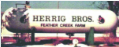
Tanque de Herrig antes de la explosión
