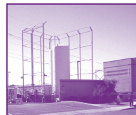
LNG fueling station
