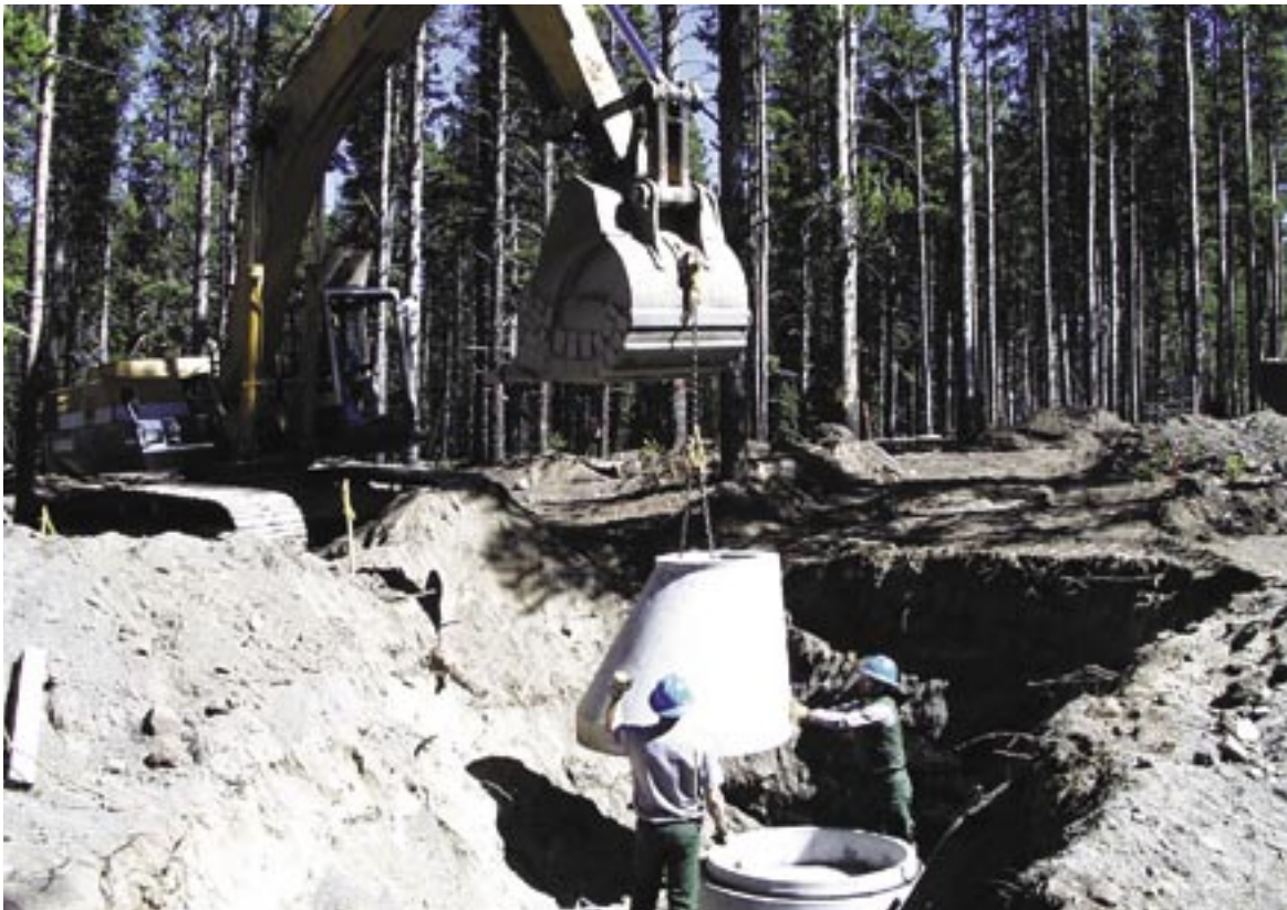
Yellowstone National Park (MT/WY/ID) está reemplazando los sistemas de alcantarillado que no funcionan bien e instalando nuevas alcantarillas en todo el parque para proteger sus recursos y prestar servicios mejores a los visitantes.
