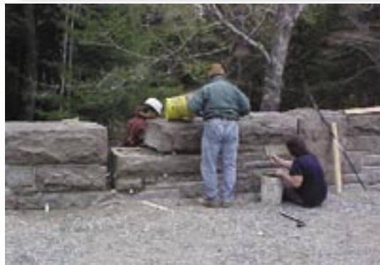
Acadia National Park (ME) está rehabilitando las superficies, puntos de observación y puentes de los caminos del parque y sistema de caminos de carruajes. El proyecto mejorará la seguridad, apariencia y el acceso por el público al sistema de caminos de Acadia.
