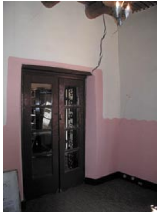
NPS está rehabilitando el Painted Desert Inn para reparar los daños estructurales y proteger esta arquitectura y diseño únicos. El Painted Desert Inn, producto del New Deal, es un Sitio Histórico Nacional. La estructura de dos pisos está ubicada en una mesa que domina el colorido desierto pintado del Petrified Forest National Park (AZ).
