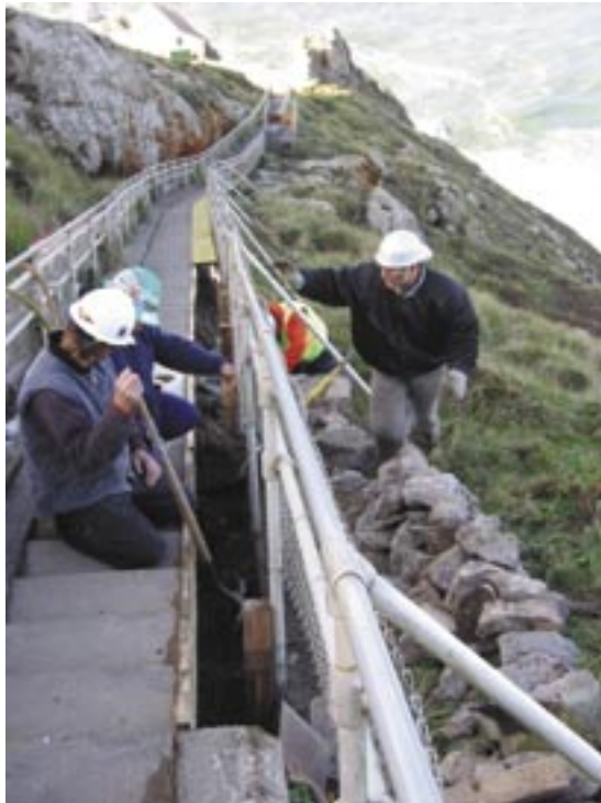
Point Reyes National Seashore (CA) reemplaza antiguos escalones de cemento y pasamanos para velar por el acceso seguro de los visitantes al histórico Point Reyes Lighthouse Complex. La muy deteriorada escalinata de 304 pasos es paralela a los empinados barrancos y es el único punto de acceso al faro principal.
