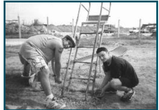
EN2 Esteban and SN Sanders pour concrete for a playground slide.
