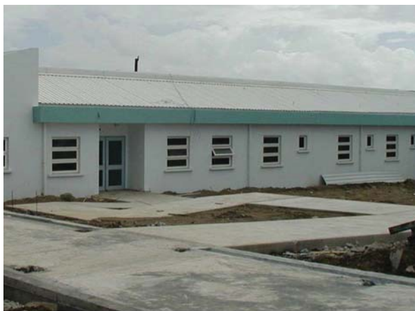
El Hospital Joseph N. France, profundamente dañado por el Huracán Georges, fue reconstruido con un nuevo pabellón de pediatría. Presta servicios a las islas de St. Kitts y Nevis. (USAID)
