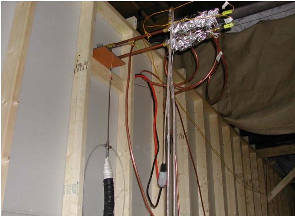
5a. Corridor Exterior
