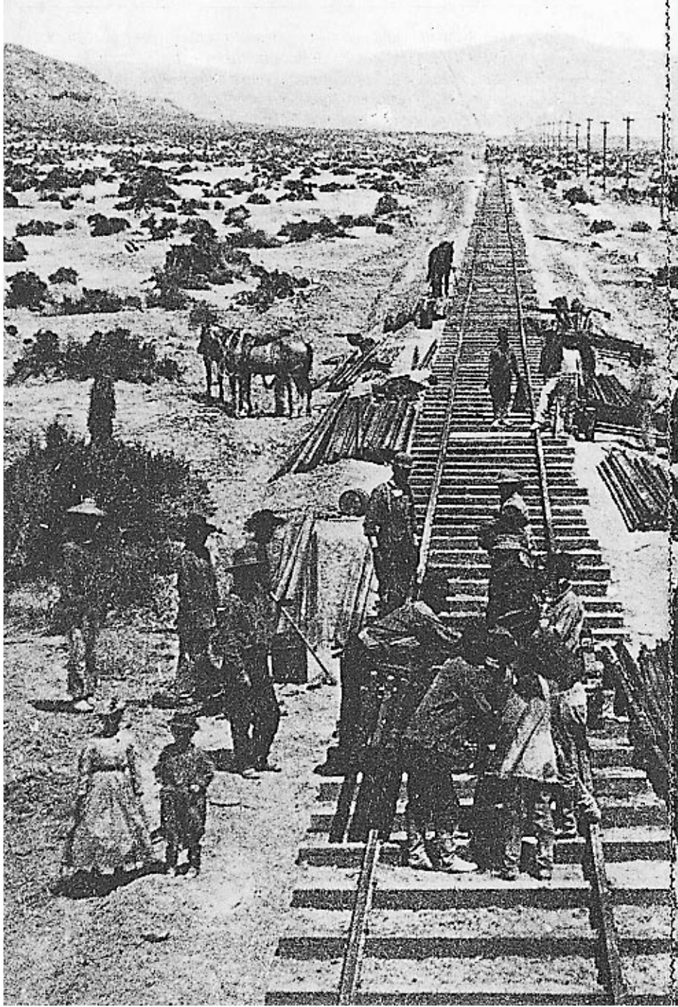
Construction du chemin de fer transcontinental, 1868.
